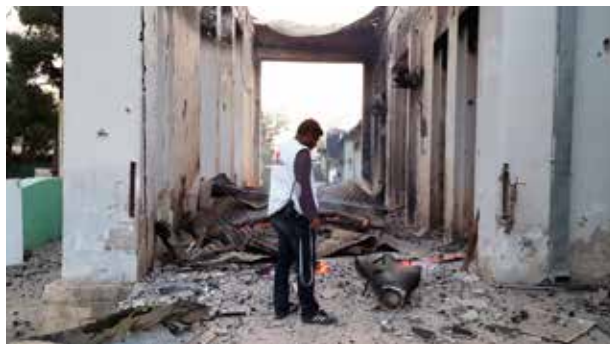
Zerstört: Die Arbeit in Kundus musste nach dem Angriff eingestellt werden (Oktober 2015).
